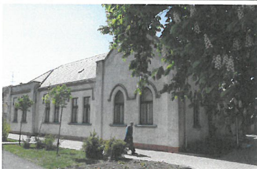
Városháza, historikus homlokzattal, Rákóczi F. u. 8., hrsz.: 699
